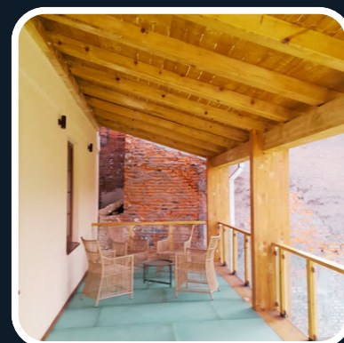
Pridvor reconstituit, pardoseală sticlă pe structură lemn
