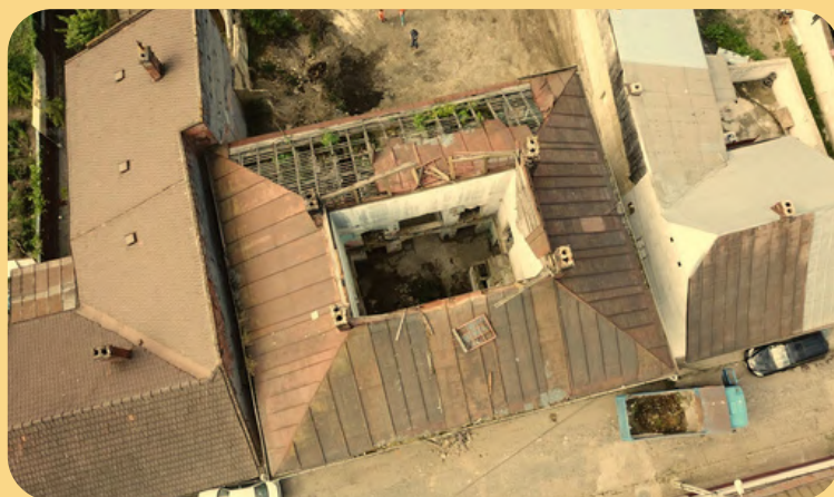
Casa filmată dintr-o drona: se vede luminatorul cazut, acoperișul parțial prăbușit, faptul că jumătate din teren - stînga a fost "achiziționat" de un vecin care a sufocat-o.
