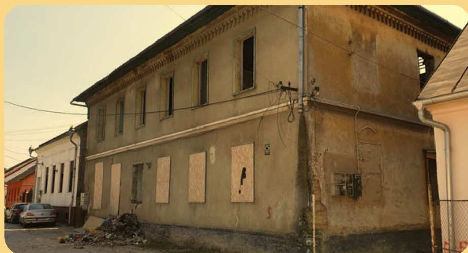
Șc. Pittner-fațada, str. Furnalelor, situația inițială.
